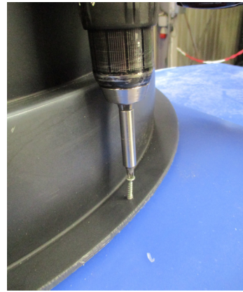
Schritt 4: Domschacht mittels Schrauben am Tank befestigen Achtung: Mittig durch Auflagefläche schrauben
