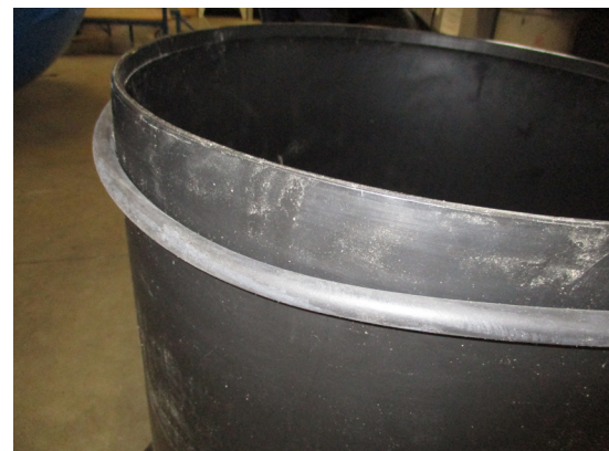
Schritt 6: Rundschnurdichtung \varnothing 18\text{mm} auf Domschachtstecken.
