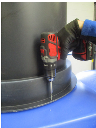
Schritt 5: Die 6 Schrauben symmetrisch rund um Domschacht verteilen Tipp: Überkreuzt anschrauben
